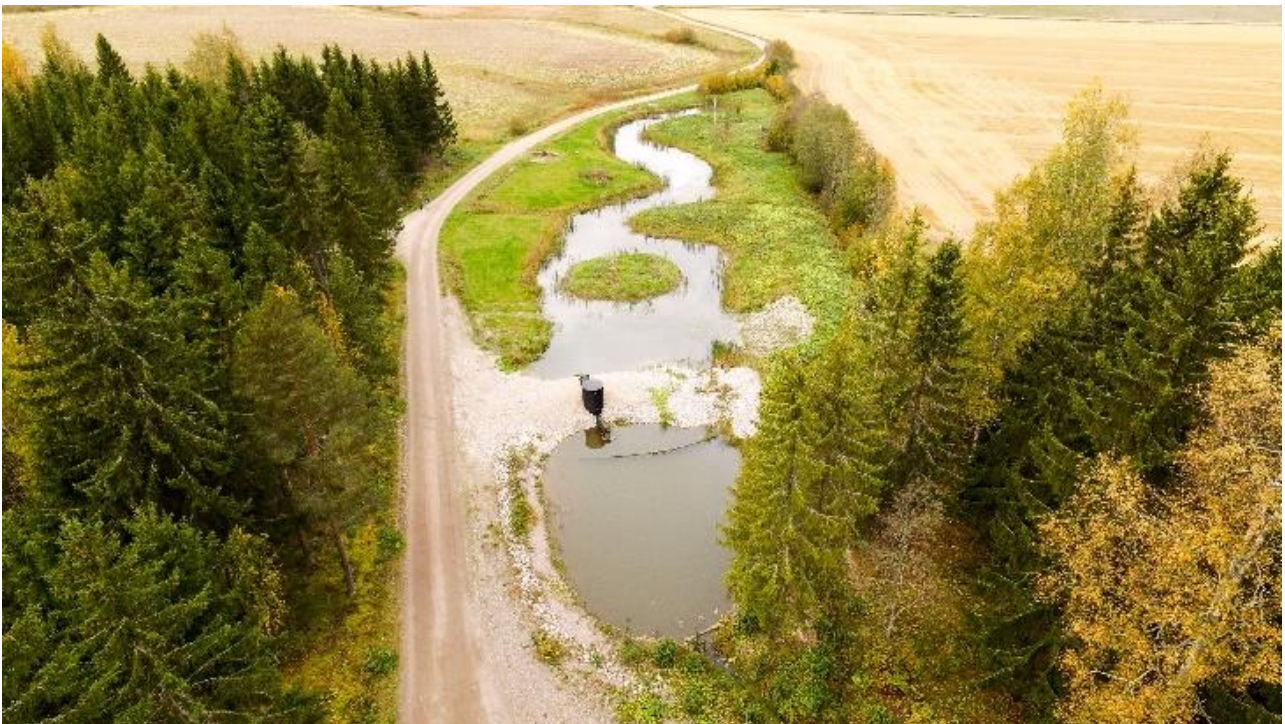
Kuva 20. Upilanojan kosteikko kemikaaliannostin. Kosteikon alkuosassa oleva mutkitteleva allas näkyy kuvassa ylhäällä. Altaiden välissä olevassa padossa näkyvä musta rakenne on kemikaaliannostin. Alapuolinen allas ja lasku-uoma sijaitsevat kuvan alaosassa.
