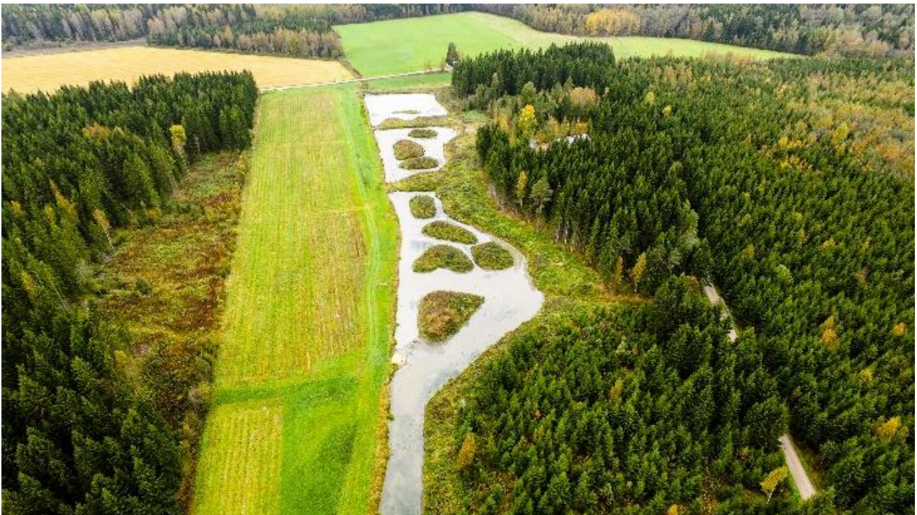
Kuva 8. Pyrylän kosteikko altaan yläosan puolelta kuvattuna.
