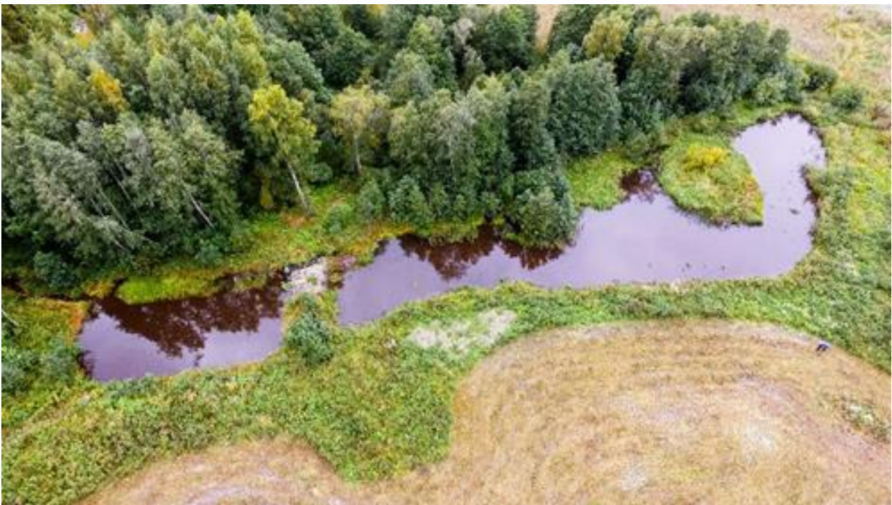
Kuva 14. Äkeenojan allas. Altaan tulouoma sekä laskeutusallasosa vasemmalla ja matalampi kosteikko-osa sekä lasku-uoma oikealla.
