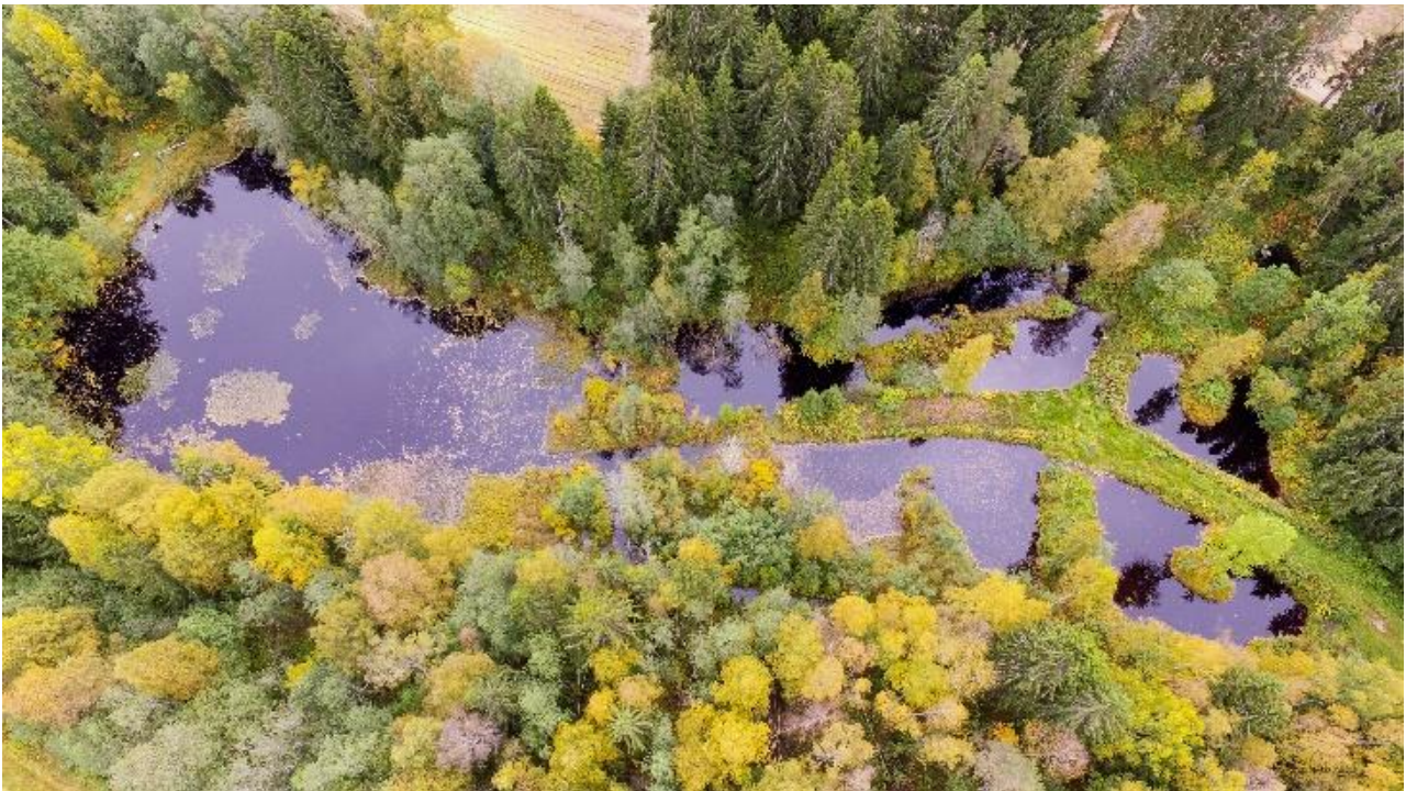
Kuva 17. Kurhilan kosteikko. Altaan alkuosassa sijaitsevat vanhat kala-altaat oikealla ja alaosassa oleva suuri laskeutusallas vasemmalla.
