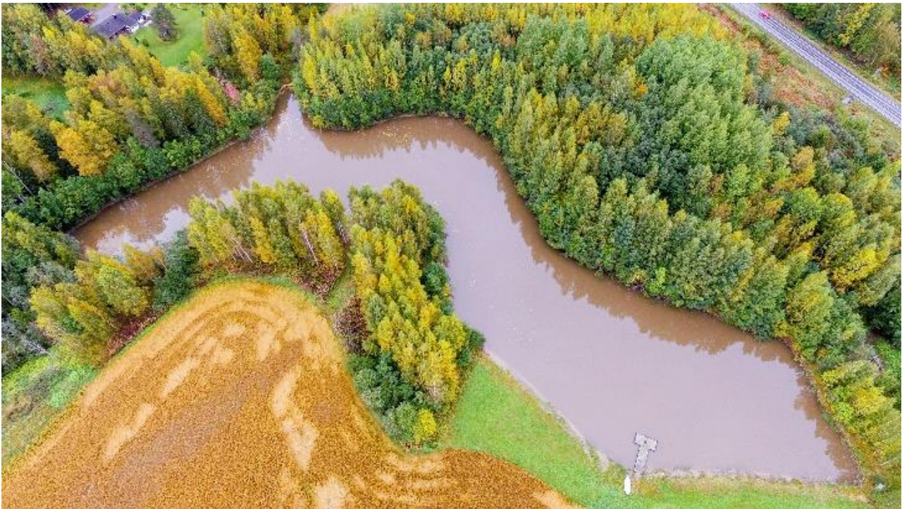
Kuva 11. Kytyänojan allas. Altaan alaosa ja munkkipato sijaitsee oikealla.
