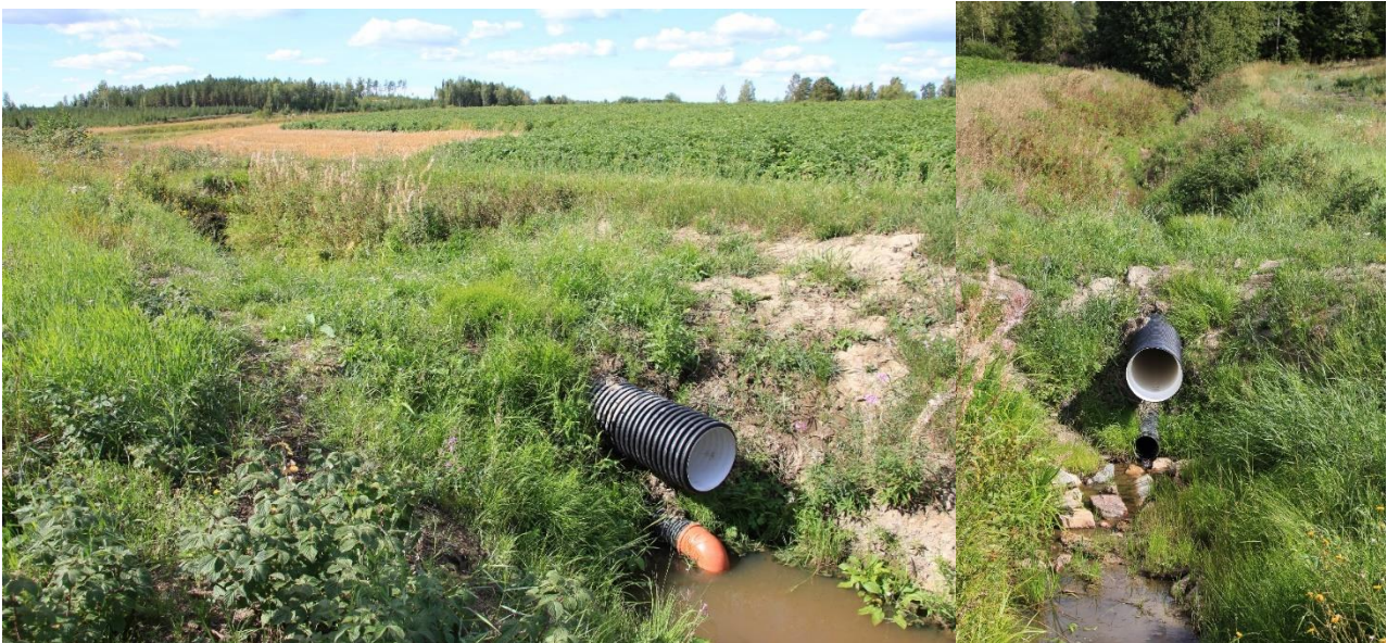
Kuva 16. Vasemmalla putkipadon yläpuoli, oikealla putkipato alajuoksulta katsottuna.
