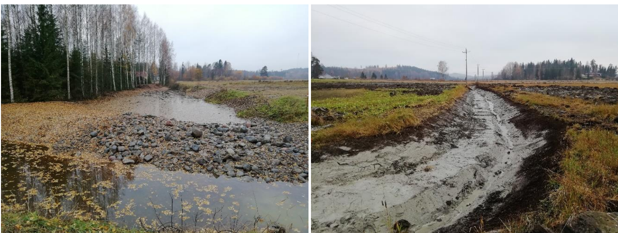
Kuva 3. Vasemmalla Piilonojaan tehty uusi laskeutusallas. Vasemmalla Piilonojan sivuhaaraan tehtyä kaksitasouomaa. Taustalla näkyy myös altaasta kaivettuja maamassoja, joilla on kohotettu alavaa pellonpintaa.
