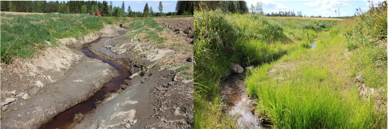
Kuva 17. Vasemmalla kaksitasouoma heti rakennusvaiheen jälkeen. Oikealla kaksitasouoma elokuussa 2018.
