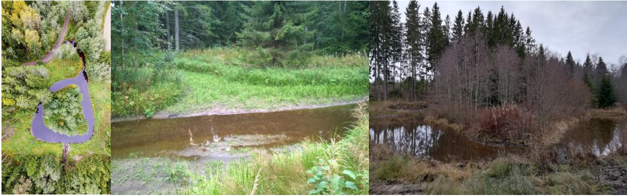
Kuva 6. Vasemmalla Pellavaloukun laskeutusallas vuonna 2017. Keskellä selvä tyhjennystarve syksyllä 2018. Altaan toinen haara oli täysin tukossa. Oikealla allas kiintoaineen tyhjennyksen jälkeen.
